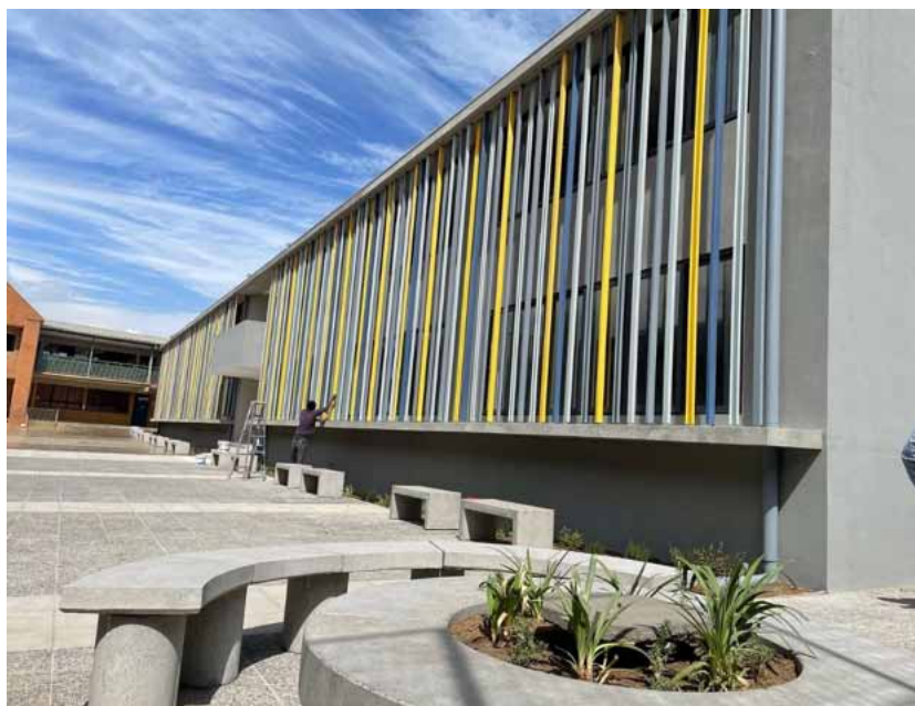
Pabellón Liceo Bicentenario San Francisco
